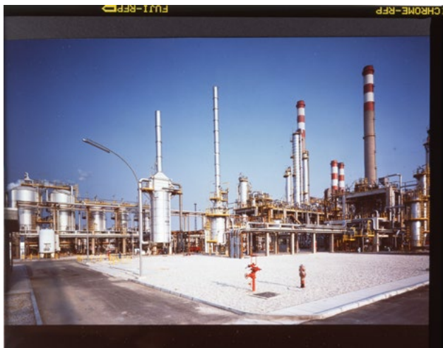
Tecnimont, Porto Marghera (Italy): 13.700 t/y Dicyclopentadiene Plant. 1989.
